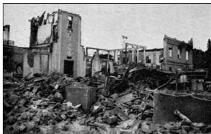
Das Zentrum von Managua nach dem Erdbeben
