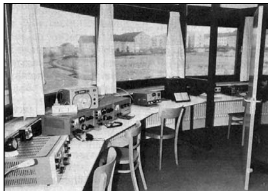
KW-Station im Turm, AFZ Baunatal
