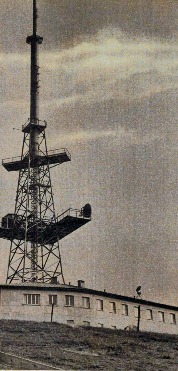
▲ Ein freitragender Rohrmast auf freistehendem Gittermast – das ist die technische Typenbezeichnung für den Mast, der auf dem Pfänder errichtet worden ist. Von ihm werden das Erste und das Dritte Programm sowie Bild und Ton des Fernsehprogramms ausgestrahlt.
